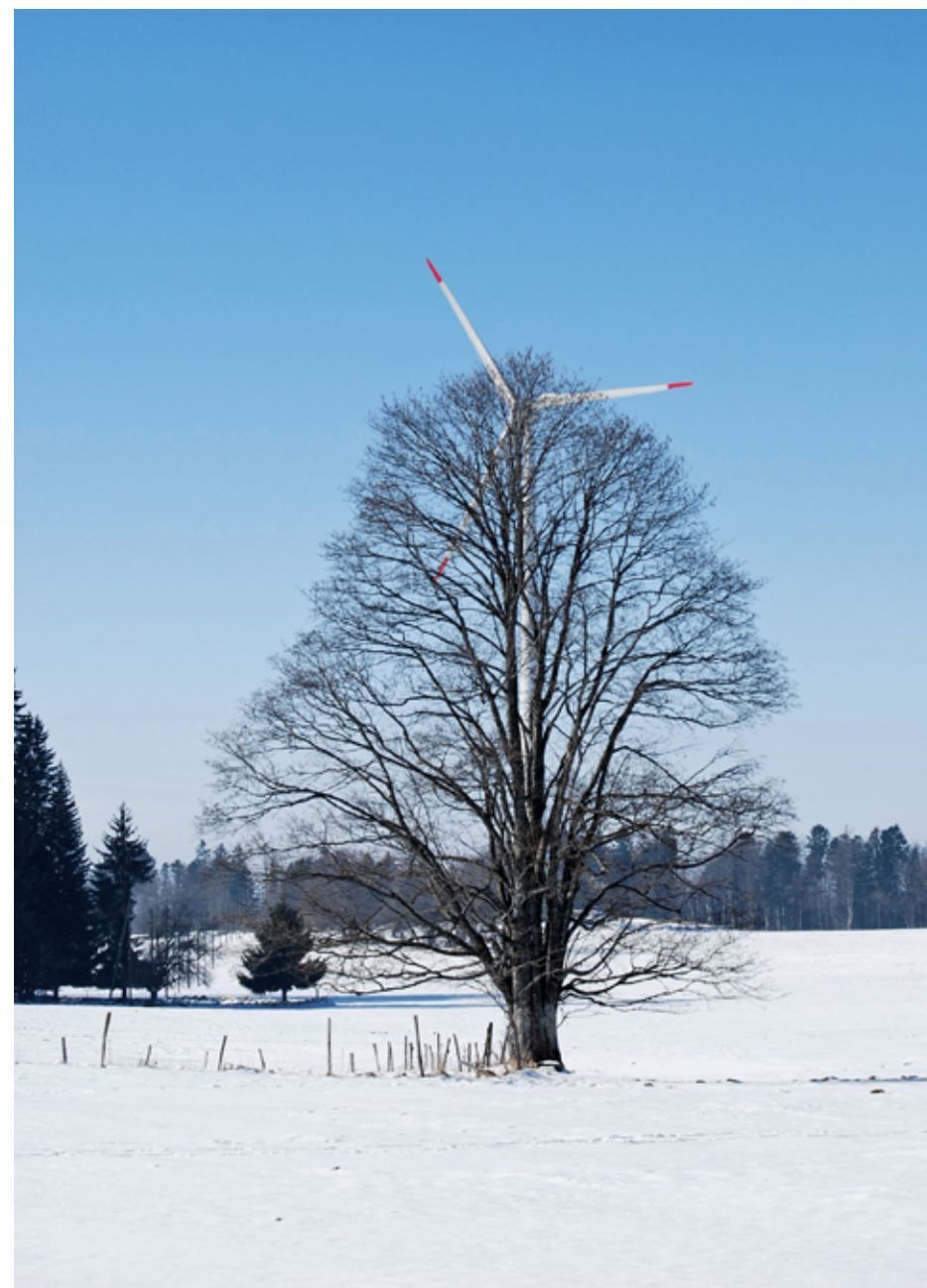
Steht nicht im Wald, aber hinterm Baum: Eine Windturbine bei Le Peuchapatte in den Freibergen im Kanton Jura.
