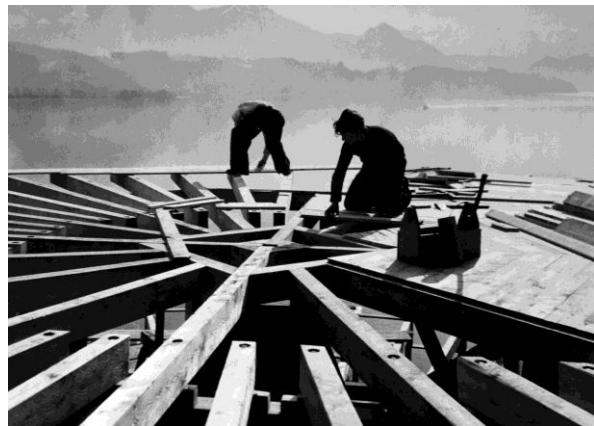
Abb. 32c, Bau der Turmterrasse
